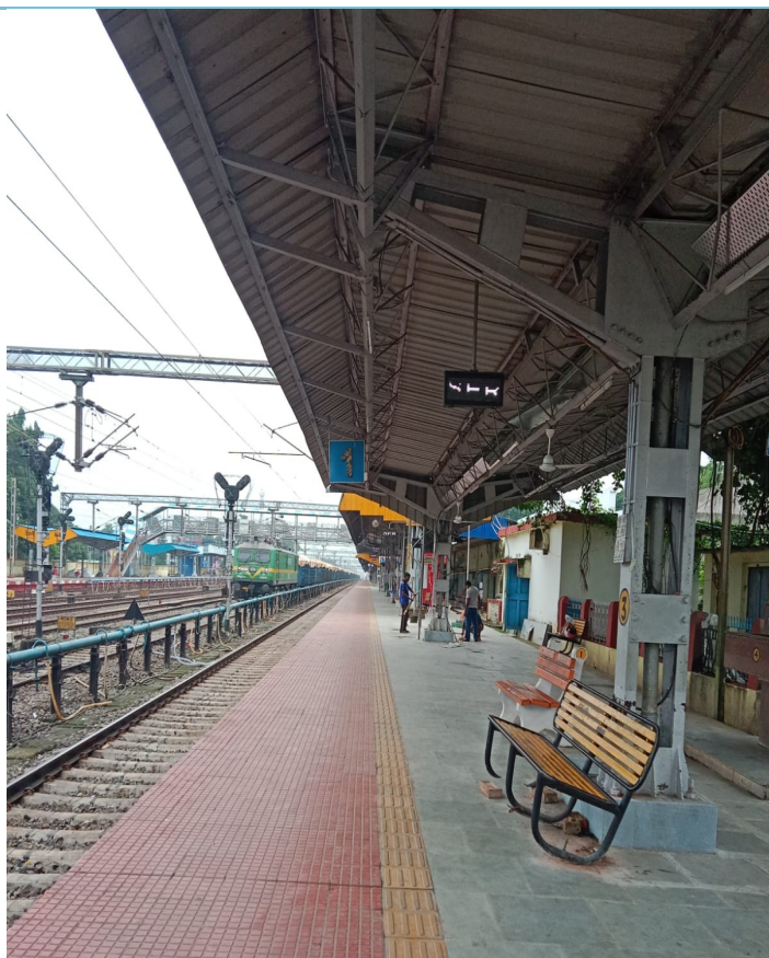
Intensive cleaning of HIJ station
