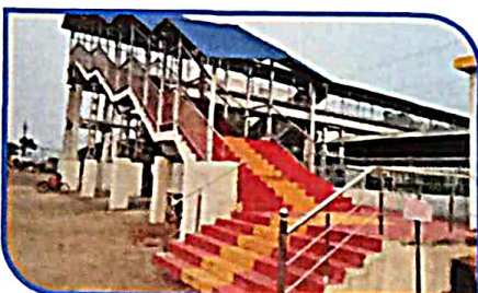
चाण्डिल स्टेशन पर नए पैदल ऊपरी पुल का निर्माण कार्य सम्पन्न।
