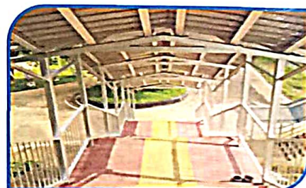
चंद्रकोना रोड स्टेशन पर नए पैदल ऊपरी पुल का निर्माण-कार्य संपन्न।
