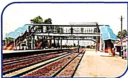
गोदापियासाल स्टेशन पर नए पैदल ऊपरी पुल का निर्माण-कार्य संपन्न।
