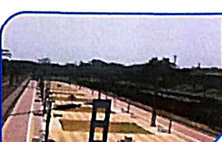
बरनपुर स्टेशन के प्लेटफार्म का सतहीकरण कार्य संपन्न।
