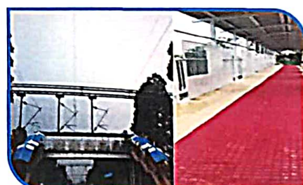
दामोदर स्टेशन पर नए पैदल ऊपरी पुल का निर्माण-कार्य संपन्न।
