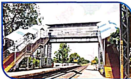
मुराडीह स्टेशन पर नए पैदल ऊपरी पुल का निर्माण-कार्य संपन्न।
